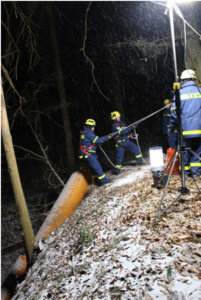
Einsatzkräfte mit Absturzsicherung
